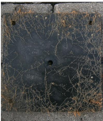
1.5 Pasieniečių postas. Priedugninės plokštelės viršutinė dalis
