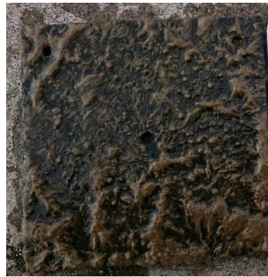
3.6 Laivyno bazė. Priedugninės plokštelės apatinė dalis
