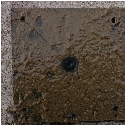
3.5 Laivyno bazė. Priedugninės plokštelės viršutinė dalis
