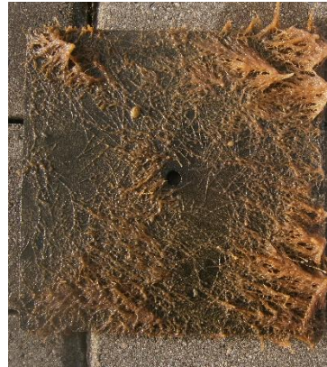
1.2 Pasieniečių postas. Paviršinės plokštelės apatinė dalis
